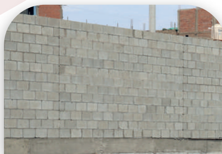
MURO REALIZADO CON KING BLOCK
