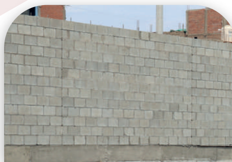
MURO REALIZADO CON KING BLOCK
