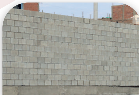
MURO REALIZADO CON KING BLOCK
