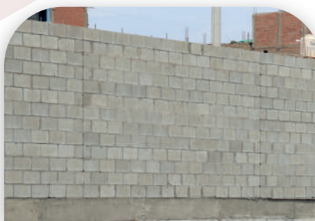
MURO REALIZADO CON KING BLOCK
